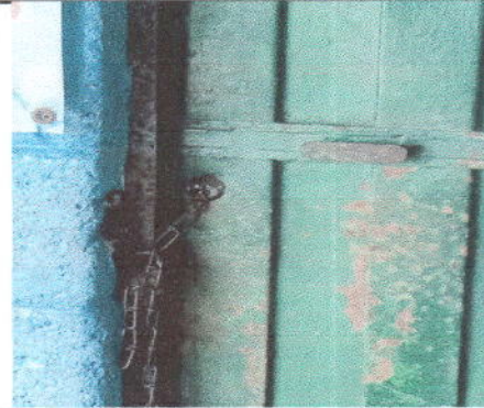
Foto 2: Sustitución de chapa
