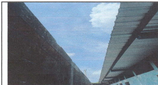
Foto 5: Sustitución de canal de metal
