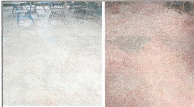
Foto 3: Sustitución de piso de cemento liquido por piso ceramico
