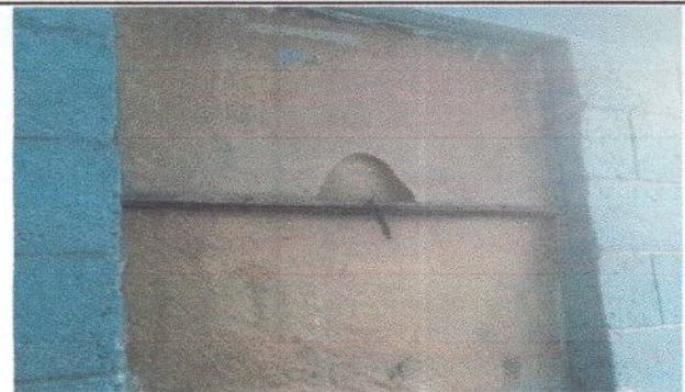
Foto 4: Sustitución de ventanas de madera por metal mas vidrio
